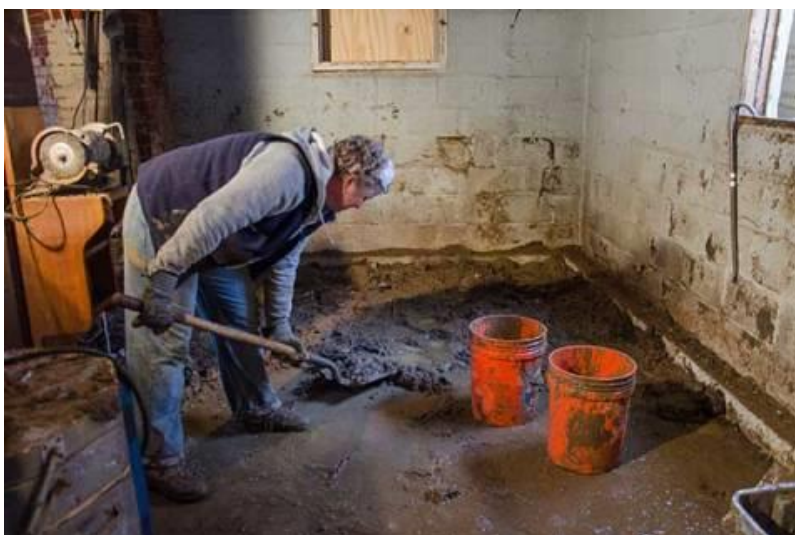
شکل ۶) تخلیه گل‌ولای با استفاده از وسائل ساده مثل سطل
